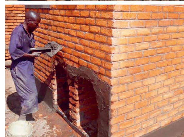
In diesen beiden Kammern werden die Fäzes getrocknet, die später zu Dünger verarbeitet werden.
