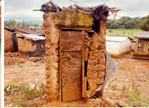
Grubenlatrinen, wie diese, sind in Ländern wie Malawi weit verbreitet. Sie sind hygienisch völlig unzureichend und sehr instabil.
