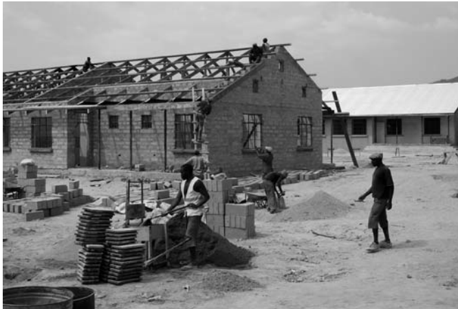
Die Lehrerunterkünfte im Rohbau
