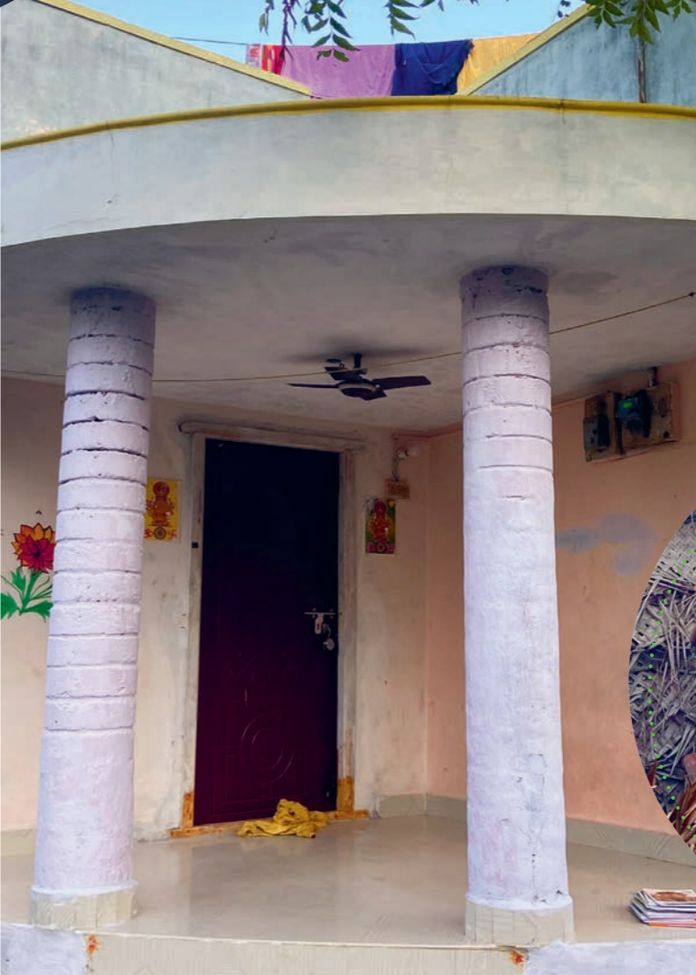
Oben: Rohbau aus 2008 kurz vor der Fertigstellung. Unten: Blick auf den Hauseingang eines DESWOS-Hauses bei meinem Besuch im März 2023
